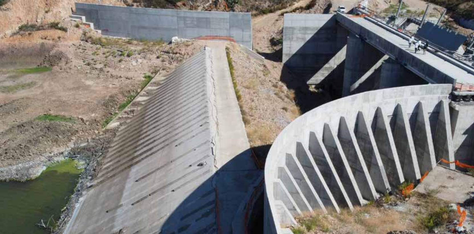
I lavori di ampliamento della diga di Maccheronis (NU) Foto: osservacantieri.mit.gov.it
