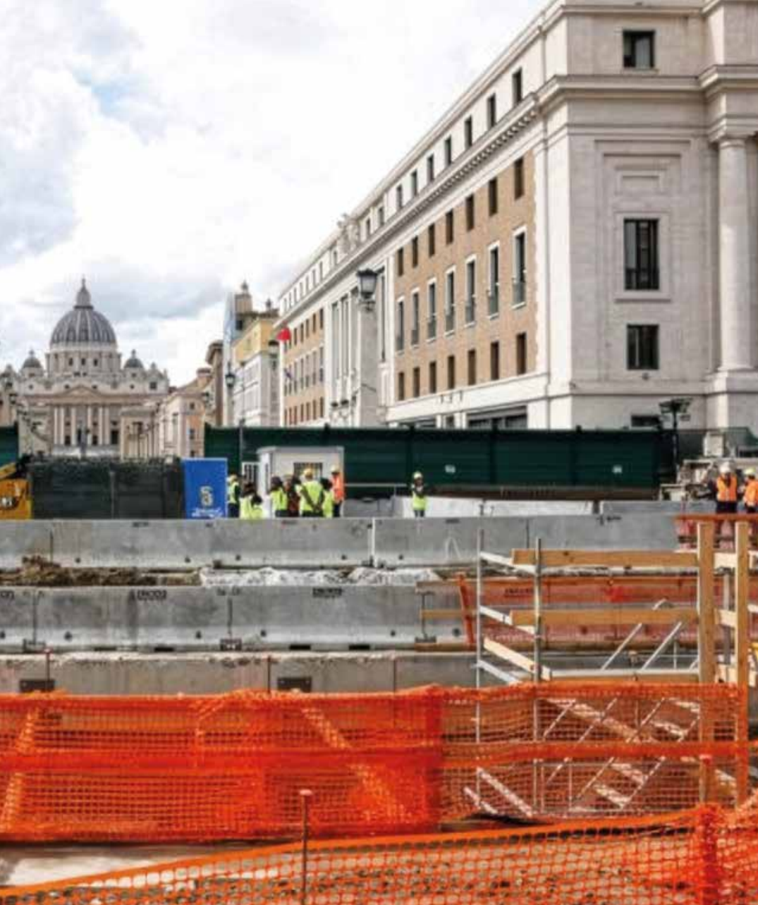
Il cantiere di Piazza Pia a Roma Foto: confineline.it
