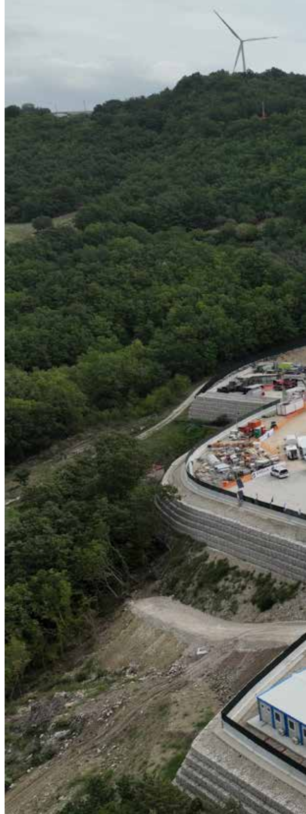
Cerimonia di inaugurazione e avvio dei lavori per il completamento della diga di Campolattaro (BN)
